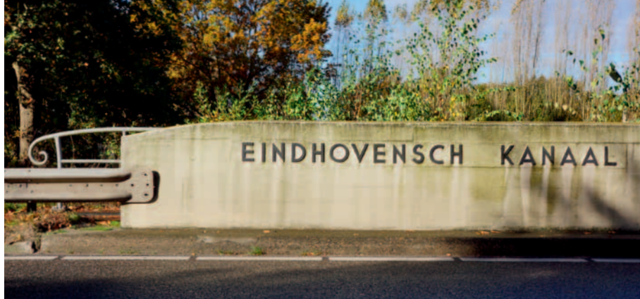
De Betonnenbrug (oftewel 'Nei' brug) tussen Mierlo en Mierlo-Hout met tekst in oude spelling. Deze brug is onlangs gesloopt en vervangen door een nieuwe viaduct.
