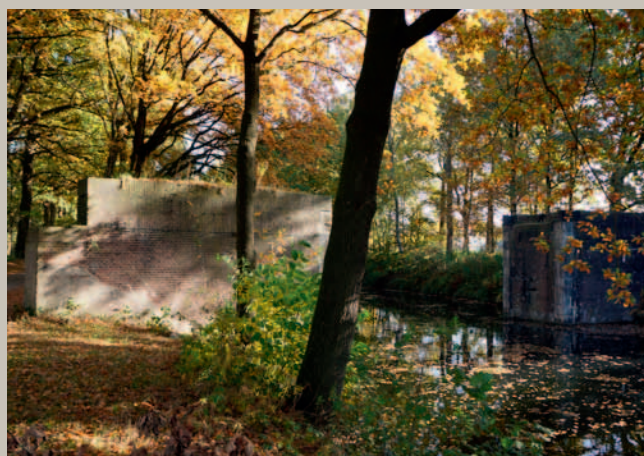
De brughoofden van de trambrug zijn bewaard gebleven.
